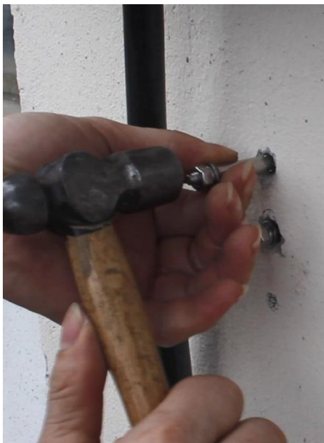
11. Enfoncez les vis d'expansion avec un marteau.
