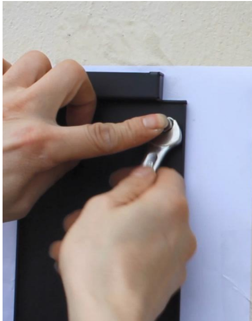
5. Serrez les vis supérieures avec une clé.
