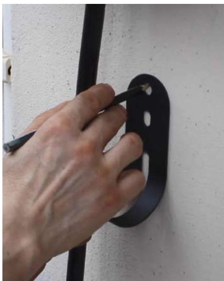
9. Utilisez un crayon pour dessiner l'emplacement où le crochet doit être perforé.
