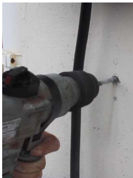
10. Use une perceuse électrique pour faire trous dans la position de dessin.
