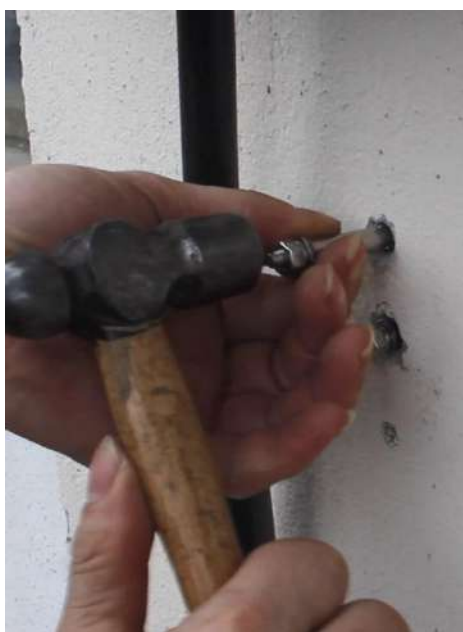
11. Enfoncez les vis d'expansion avec un marteau.
